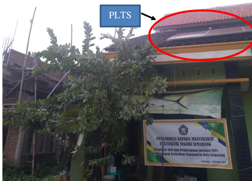
Gambar 5 Pemasangan PLTS diatas bangunan kelurahan mangunharjo
