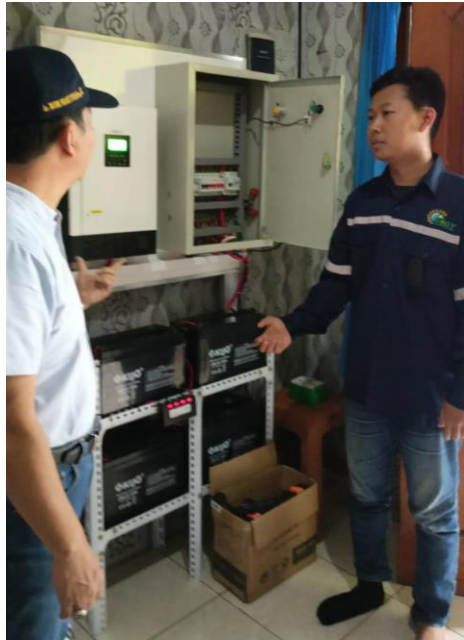
Gambar 6 Pemasangan komponen pendukung PLTS di kelurahan mangunharjo
