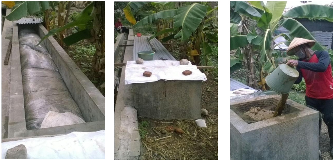
Gambar 4. Eco-biogas digester dari plastik dan bak pengaduk kotoran
