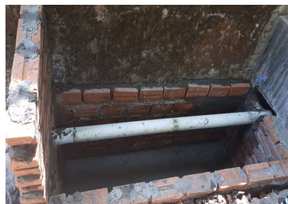
Gambar 1. penataan ruang produksi dan pembuatan bak pencucian UKM RIFKY
