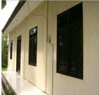
Gambar 5. Gudang penyimpanan pakan
